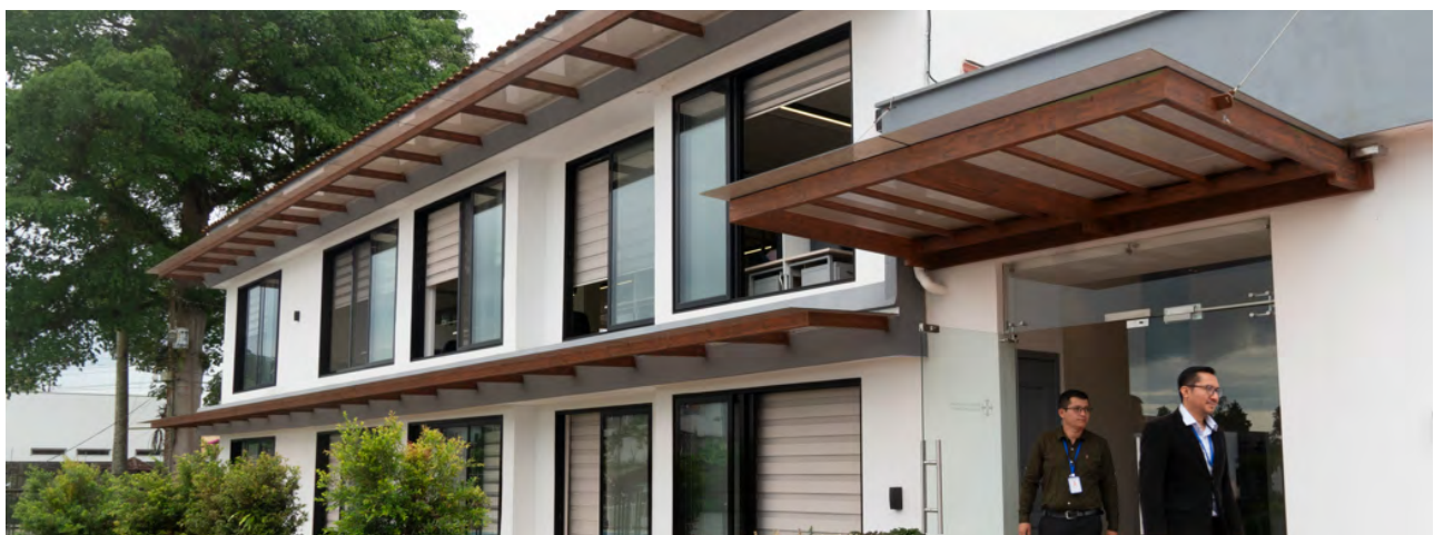
Remodelación fachada externa del Edificio San José. Fuente: Dirección de Recursos Físicos
